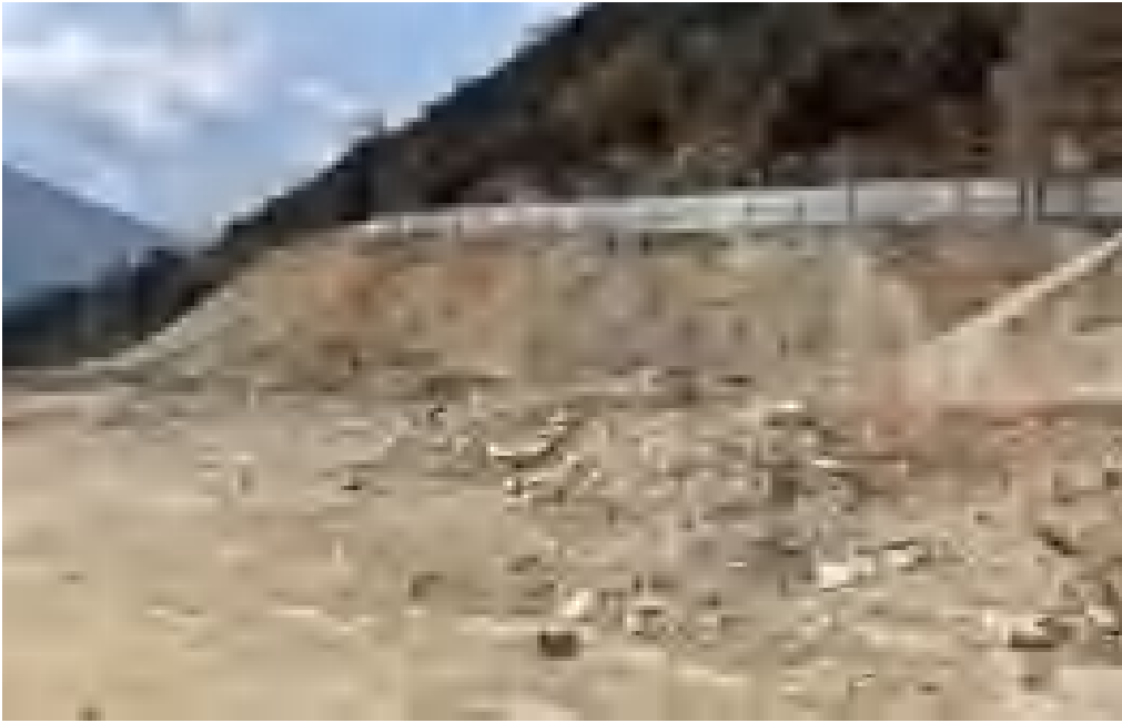
德钦县城弃土场现状
